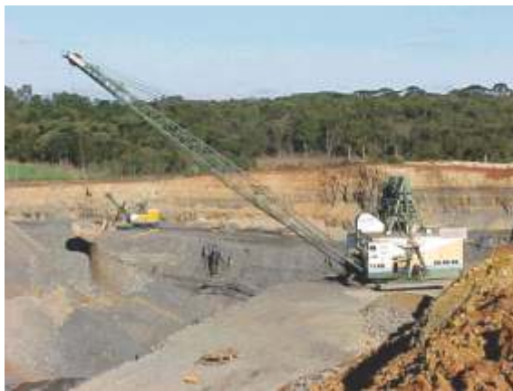
Escavação na mina
