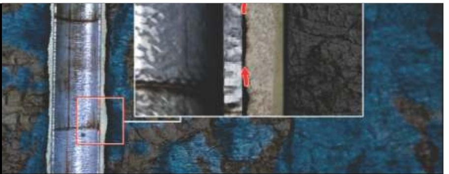
As imperfeições naturais de concretagem geram vazamentos de metano
