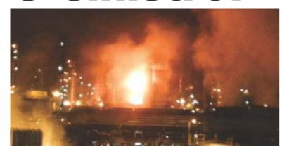
O rompimento de uma tubulação nas proximidades da bomba de carga para os fornos da U2100 (Unidade de Destilação), entre a P49 e P11, causou uma explosão na Refinaria Presidente Getúlio Vargas (Repar), em Araucária. O acidente ocorreu por volta das 22h30 do dia 28 de novembro. O incêndio gerou labaredas com altura superior aos 50 metros e só foi controlado uma hora mais tarde.
