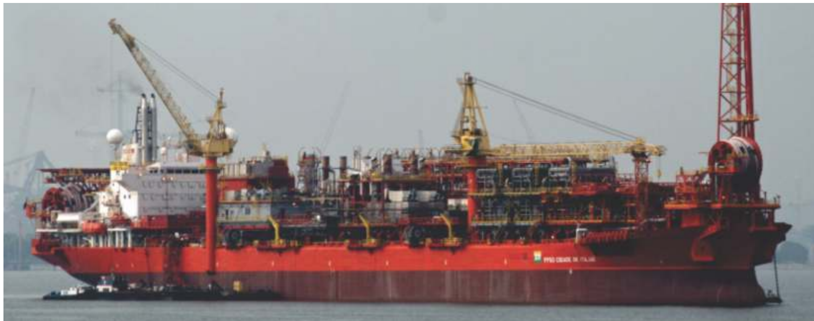
► Navio-plataforma FPSO Cidade de Itajaí faz a exploração de petróleo na UO-Sul
